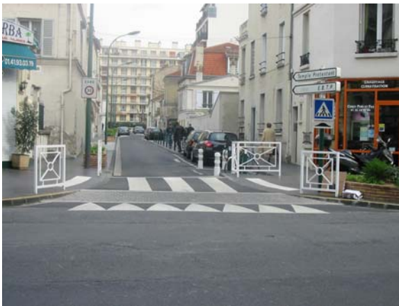
Passage piéton surélevé rue Monmory
